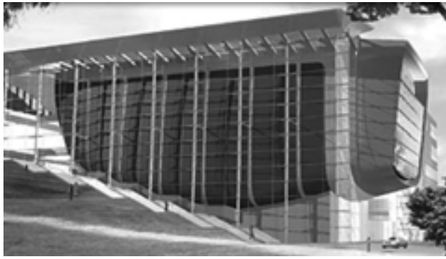
建設中の芸術センター
