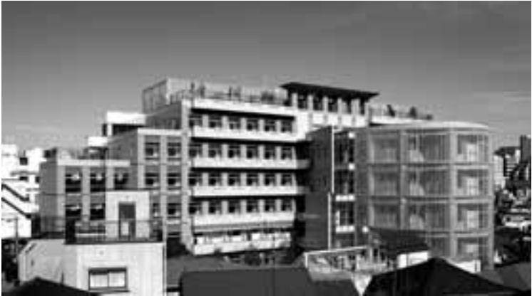
新教室棟の全景です。本館との調和を図る色調です。
