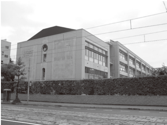
校舎の外壁は打ち放しのコンクリート
