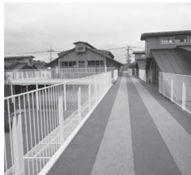
廊下の屋根部分につくった通路
