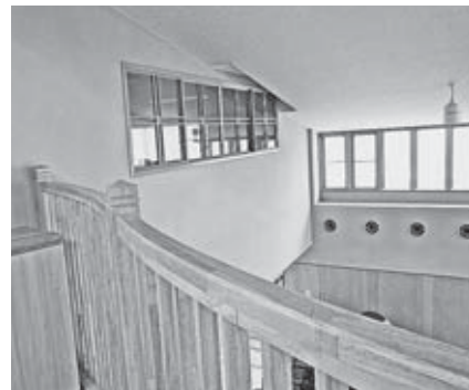
園舎2階より（流線形の手すり、高さに変化がある天井）国産の木材を全面に使用している
