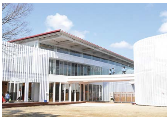
フェンスに有孔折板を使用した新園舎の外観
