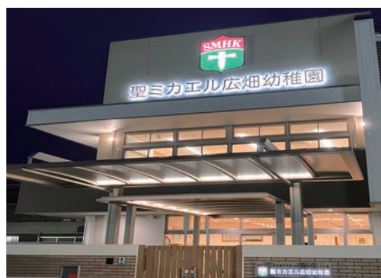
夜間でも存在感のあるサインプレート
